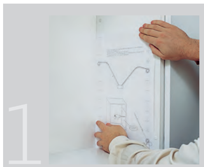
1 Colocar la plantilla apoyándola en la base inferior y al fondo del mueble.
